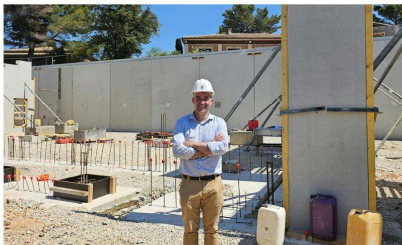
Sur le chantier du cellarium, Gabriel Teyssier, responsable de Via Caritatis, structure associée au monastère, explique que le lieu sera doté d'une isolation performante. Photo Sylvie Royer
